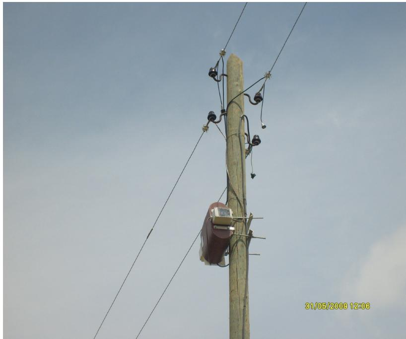
Uređaj VROT 18 napaja monofazno konzumno područje udaljeno 1500m od pripadajuće transformatorske stanice (TS 10(20)/0.4kV,250kVA).
